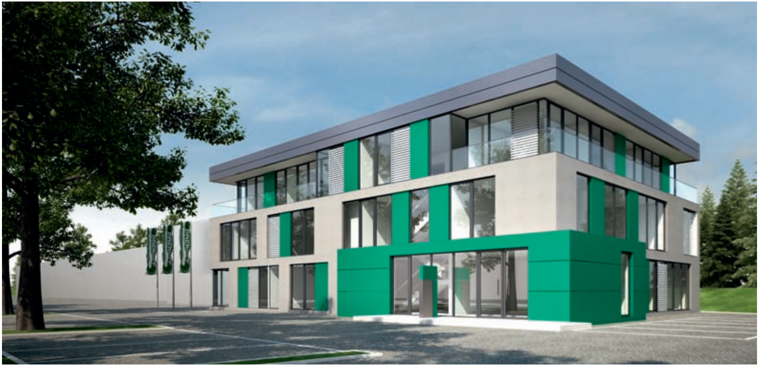
Das neue Verwaltungsgebäude von Drekopf am Hauptsitz in Mönchengladbach wird als Passivhaus gebaut und unterstreicht so die Firmenphilosophie des Unternehmens.
